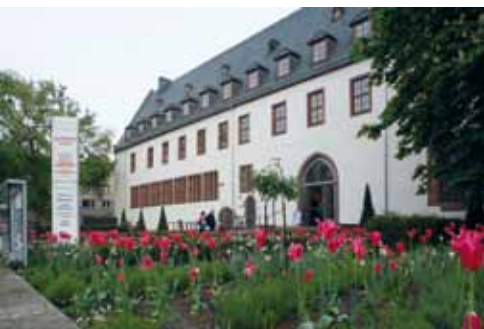
Im umfassend sanierten und modernisierten Karmeliterkloster, wo das Archiv seit 1959 untergebracht ist, bestehen optimale Bedingungen für die Geschichtsvermittlung.
