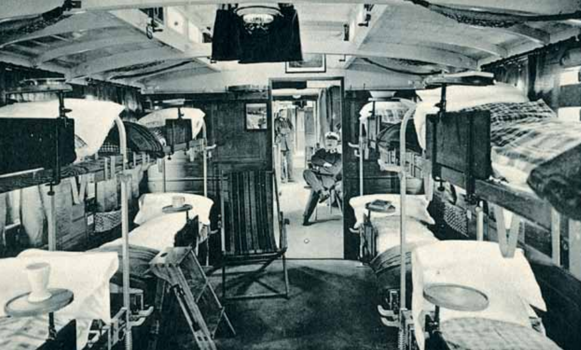
Lazarettzug „Großherzogin von Hessen“, Innenansicht eines Krankenabteils, Anfang 1915 (Stadtarchiv Darmstadt, ST 53)
